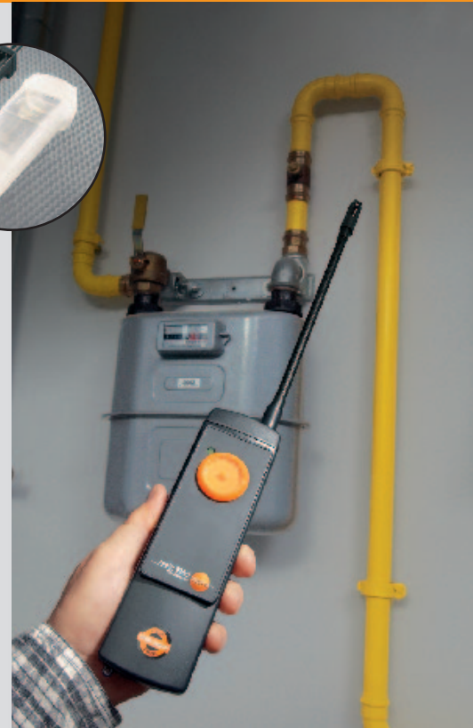
Dichtigkeitskontrolle an Hausgas-Leitungen
