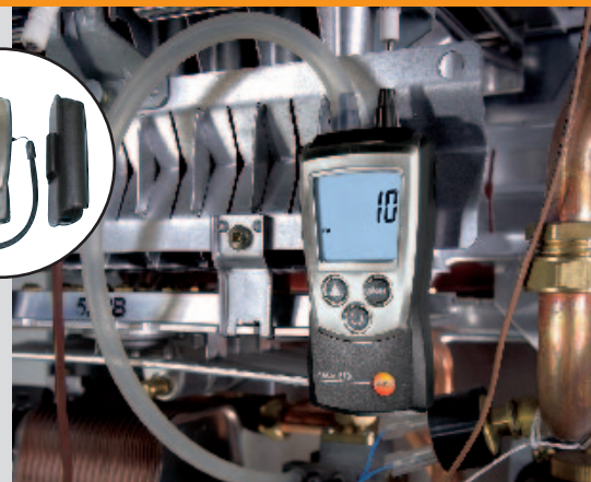
Differenzdruckmessung an einer Gastherme
